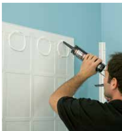
4 Encollage des panneaux au mastic-colle
