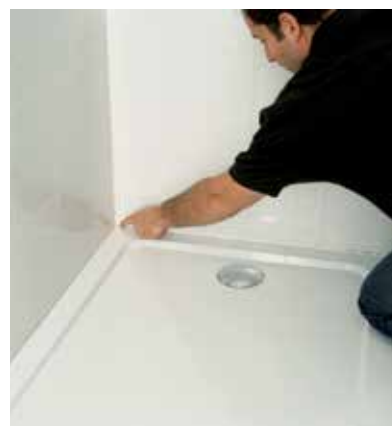
6 Pose d'un cordon silicone
