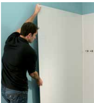
5 Pose des panneaux
