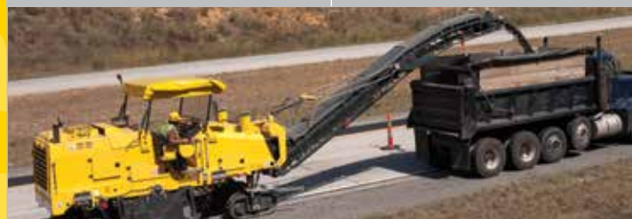
CHANTIERS D' AUTOROUTES
