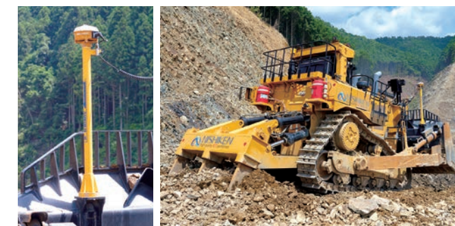
(左) 3D施工に対応したマシンを他社に先駆けて導入した。 (右) 油圧ショベルを従えて現場をリードするD10。
