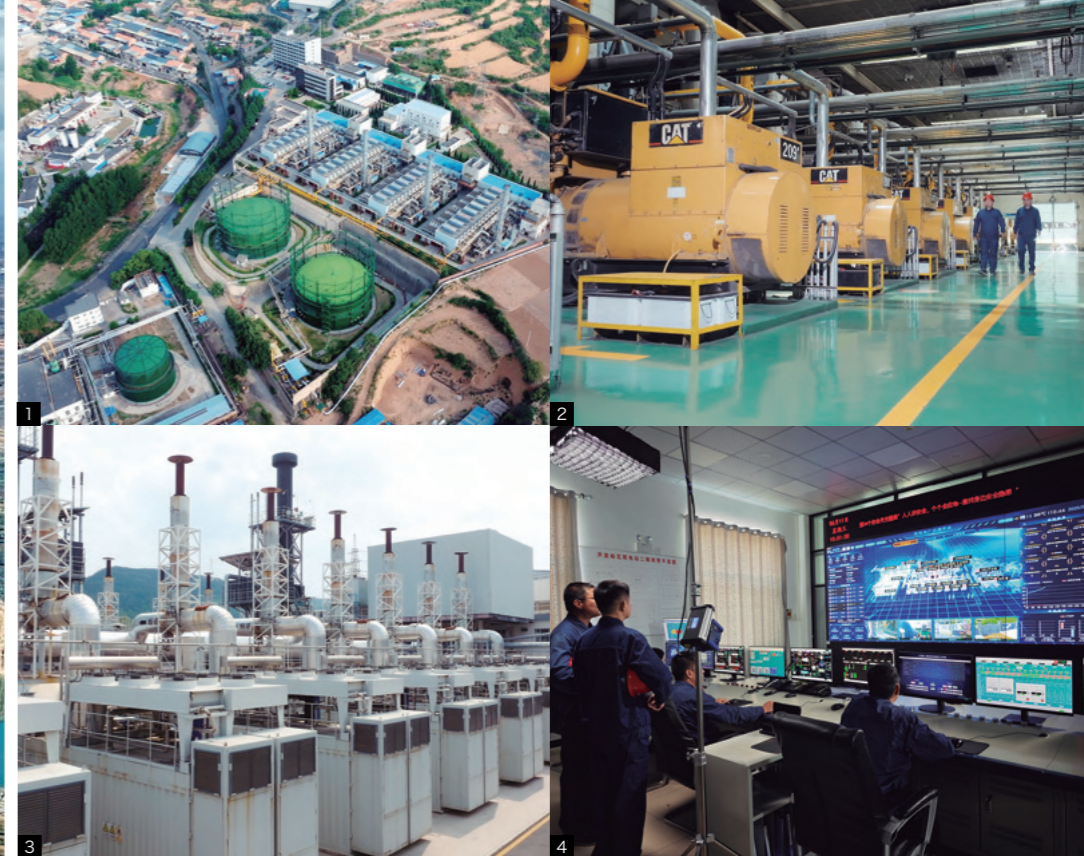
1.2. 沁水寺河ガス発電所はCat G3520C炭鉱メタン発電機セット60台を導入し、ガスを電気や熱エネルギーに変換し供給している 3.4. 芦家峪スマート発電所は中国で初めてスマートプラットフォームを備え、全ての運転データを3次元で可視化できる発電所
