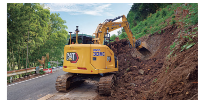
道路拡幅のため斜面を削る315。
