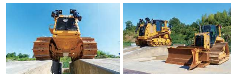
D10Tなどの大型ブルドーザをメンテナンス中の猪飼工場。
