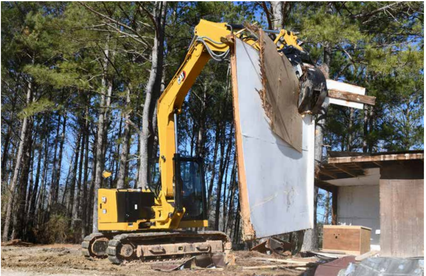
Hydromechanischer Universalgreifer
