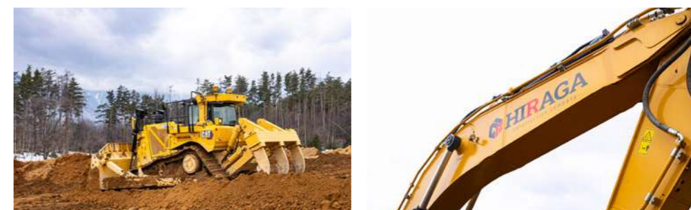
写真上:社長の平賀健太様。取材時の丁寧なお話しぶりに、社員とのコミュニケーションを大切にしている姿勢が表れていました。 写真下左:現場の土を均すブルドーザーD8T。ブレードの高さや角度はICTによって自動制御されます。 写真下右:油圧ショベルのブームに入られた平賀建設様のロゴマーク
