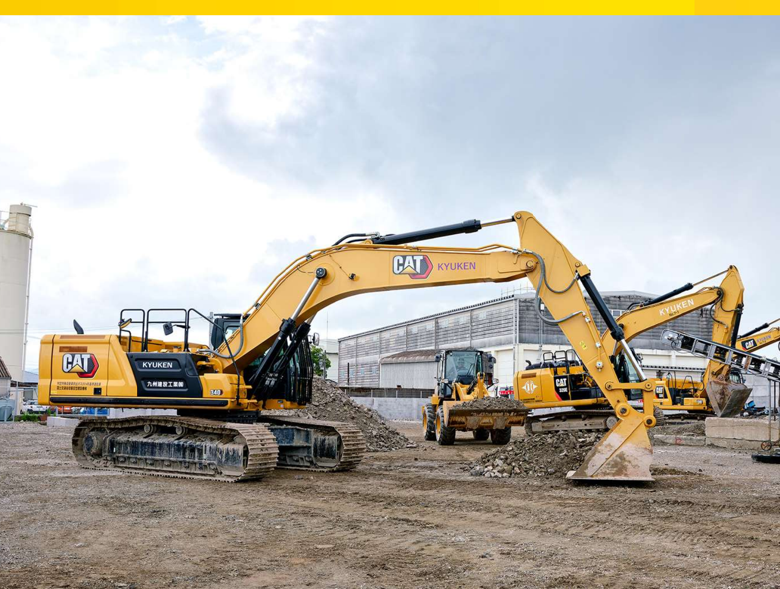
Catマシンが稼働するリサイクル場の南側には倉庫と生コン工場が隣接。
