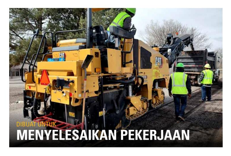
Engine yang hemat bahan bakar dan sistem konveyor yang efektif membantu memberikan tenaga dan kinerja yang diperlukan untuk memenuhi tuntutan pengupasan hingga pengerasan jalan dari waktu ke waktu.
