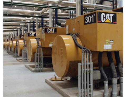
*JAMG es la empresa de extracción de carbón más grande de China que usa gas metano de minas de carbón (CMM, coal mine methane) para producir generación de energía para la mina.*
