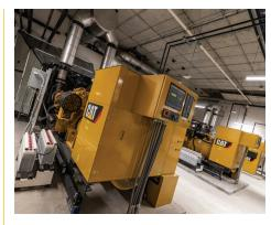
Grupos electrógenos diésel Cat<sup>®</sup> C32 con alta La densidad de potencia reduce los costos totales del sitio. preparación, transporte e instalación, y al mismo tiempo requiere menos espacio general.
