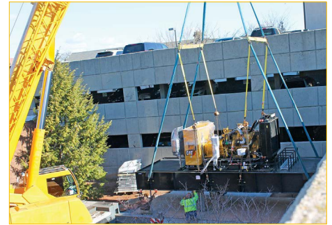
Instalación del generador bicombustible Cat® C27.
