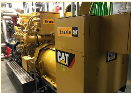
*Eneria Belgium diseñó e instaló un sistema CHP que cuenta con un Grupo Electrónico G3512H Cat® de alta eficiencia.*
