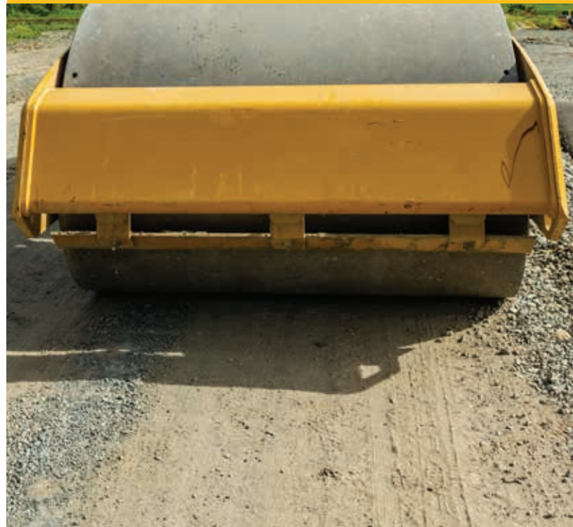
Construction d'une section de test.
