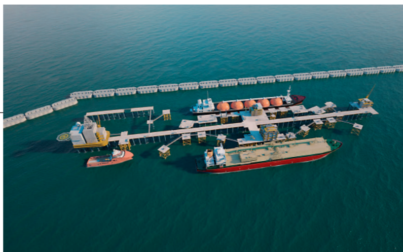
大西洋上に建設された天然ガス生産施設。
