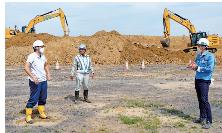
現場取材に協力して下さった土木課長の吉田正和様(中央)。*左は日本キャタピラー 石巻営業所の佐々木部品サービスセールス、右は下館マシンセールス。
