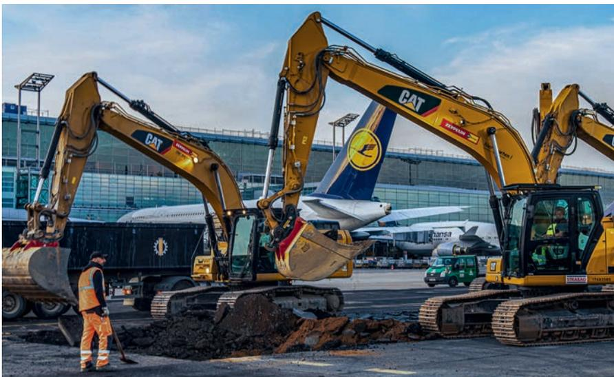
также меняем несущее основание». Кроме того, при реконструкции рулѐжной дорожки в неё встраиваются трубы и монтажные люки для электрической подсветки.
