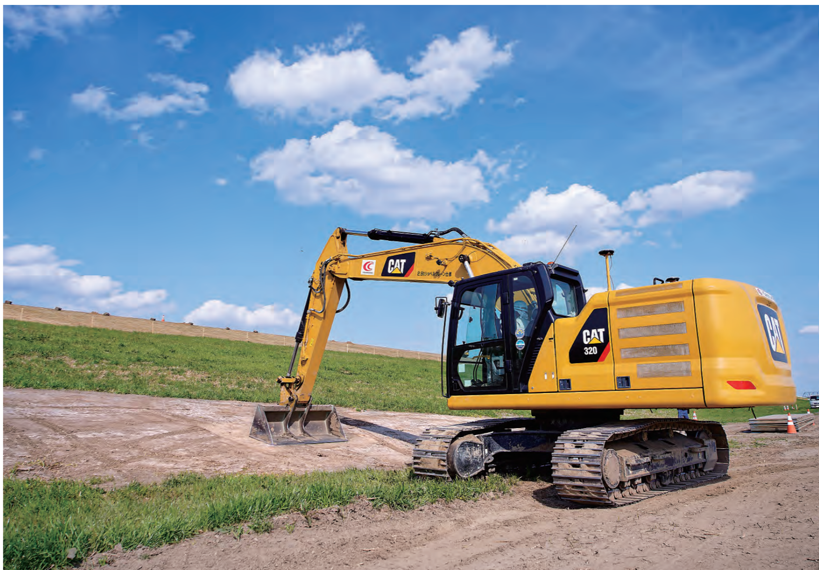
利根川左岸栄西堤防整備工事の現場。320が3D施工で整形した堤防法面を張芝緑化すれば工事は完了です。
