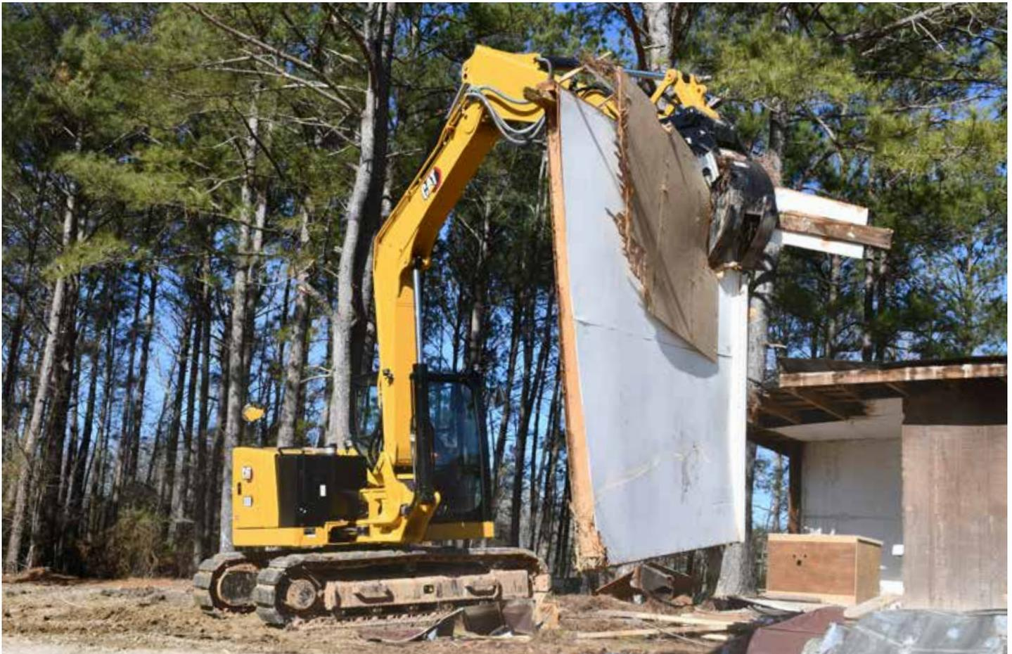
As **Garras de Demolição e Classificação** foram projetadas para uma movimentação de materiais rápida e produtiva. Capazes de carregamento de produção de alto volume e classificação precisa, elas aumentam a produtividade e a eficiência da operação. As garras podem manipular tudo das demolições primária e secundária à reciclagem para fazer o trabalho.
