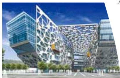
◀ 阿里巴巴淘宝第一阶段IDC发电机房安装工程。
