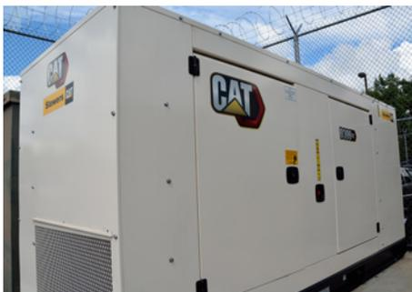
*Le groupe électrogène diesel Cat® D300 GC utilise le même espace ainsi que les réservoirs de carburant diesel déjà installés dans l'établissement pénitentiaire.*
