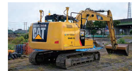
Cat 313の取材帰りに立ち寄った静岡市内(立石エリア)の遊水地掘削工事現場。320(写真上)と312F(写真下)がICT施工で対応しています。
