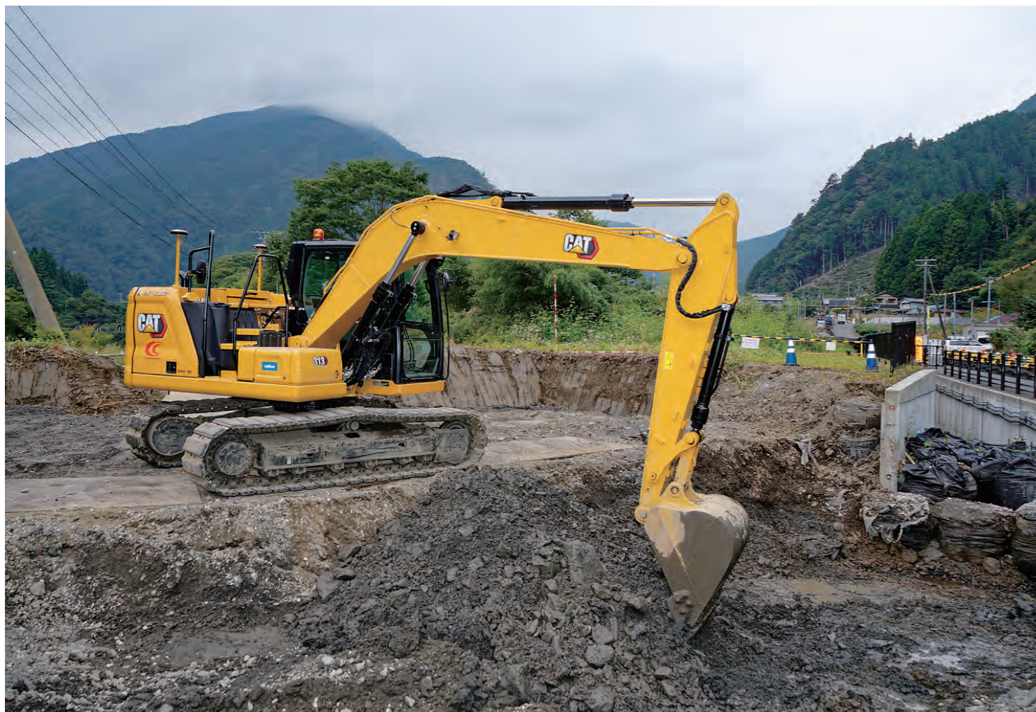
安倍川水系ウラの沢流路工事で活躍するCat 313。標準搭載されたベイロードシステムで正確な積込みを実現。
