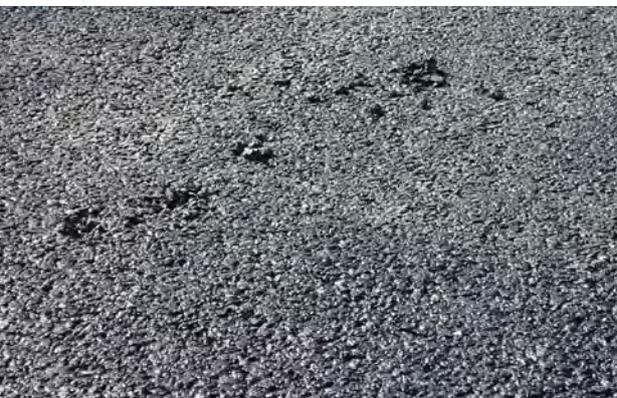
*Ausgerissene Stellen in der frischen Einbaubahn entstehen durch Festkleben von Asphalt an der Bandage.*
