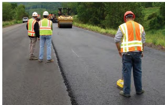
*Die Asphaltverdichtung wird von der Einbaubohle begonnen und von Walzen, die unmittelbar hinter dem Asphaltfertiger arbeiten, vollendet.*
