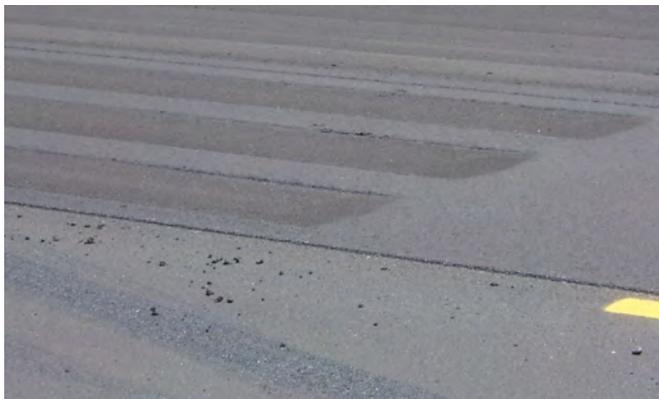
*Reifenspuren, die die Gummiradwalze hinterlässt, können im Normalfall von der zur Endverdichtung eingesetzten Walze ausbügelt werden.*
