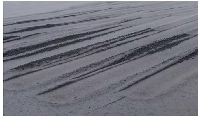
*Tiefe Reifenspuren, die beim Arbeiten auf einer dicken Schicht aus weichem Mischgut entstehen, sind schwer auszubügeln.*
