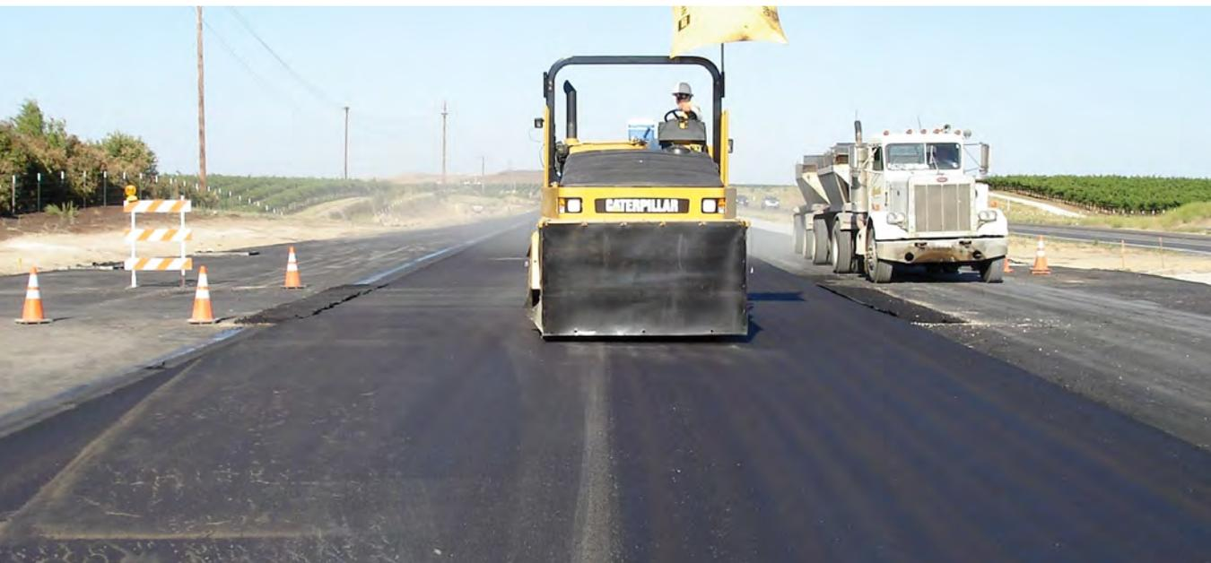
*Versiegeln einer Heiß/Kalt-Längsnaht mit einer Gummiradwalze.*
