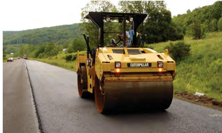
*In der Zwischenverdichtungsphase sollte bei Vibrationswalzen eine kleine Amplitude eingestellt sein.*
