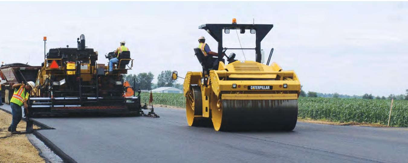
*Ein Versiegeln der Längsnaht während des ersten Übergangs verbessert das Aussehen der Naht.*
