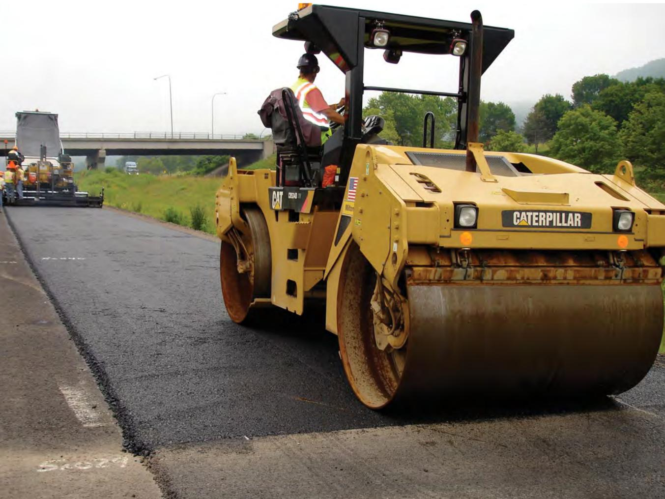
*Die zur Anfangsverdichtung eingesetzte Walze beginnt mit dem ersten Schema und bügelt die beim Verdichten der Naht auf dem Asphalt hinterlassenen Bremsspuren aus.*
