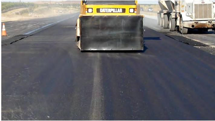
*In der Zwischenverdichtungsphase sind Gummiradwalzen beim Verschließen von Heiß/Kalt-Längsfugen effektiv.*
