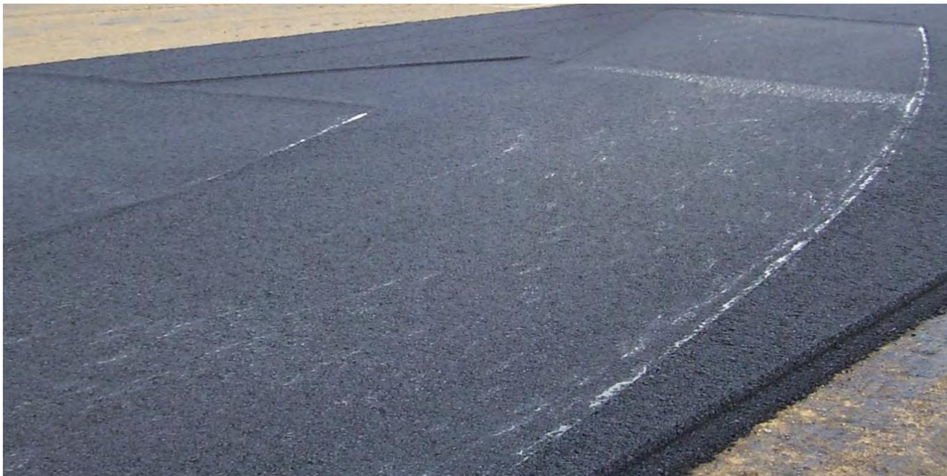
Durch wiederholtes Anhalten und Reversieren auf derselben Fläche würde der frisch verlegte Asphalt überstrapaziert werden.
