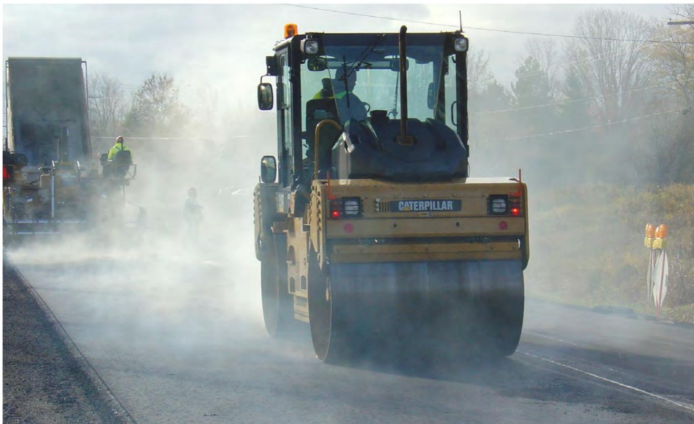
*Ein gleichmäßiges Arbeiten des Fertigers und der zur Anfangsverdichtung eingesetzten Walze sind entscheidend für das Erreichen einer gleichmäßigen Dichte.*
