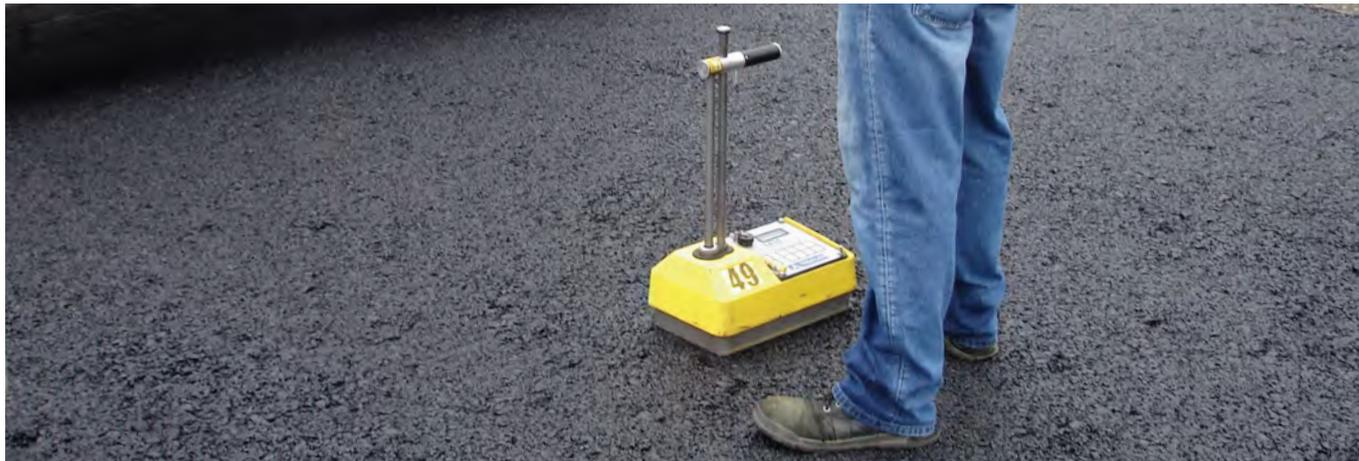
Prüfen Sie die Dichte der von der Einbaubohle verlegten Einbaubahn, bevor mit dem Verdichten begonnen wird. Die Kenntnis der Dichte hinter der Einbaubohle wird Ihnen bei der Wahl der Amplitude und der Anzahl der Übergänge, die zum Erreichen der geforderten Dichte benötigt werden, nützlich sein. Prüfen Sie die Dichte hinter der Einbaubohle an verschiedenen Stellen über der Breite der Einbaubahn.
