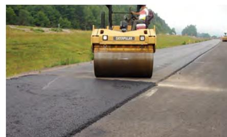
**Praktischer Hinweis:** Caterpillar empfiehlt dem Team, die Höhe der verdichteten Anfangsnaht zu messen. Dann ist dieser Messwert von der Dicke der unverdichteten Einbaubahn, die in der letzten Arbeitsschicht verlegt wurde, zu subtrahieren. Das Ergebnis ist die genaue Dicke der Anfahrhilfe. Wenn z. B. die Höhe der verdichteten Quernaht 40 mm beträgt und die Dicke der unverdichteten Einbaubahn, die von dem Fertiger verlegt wurde, 50 mm, dann sollten die Anfahrhilfen möglichst 10 mm dick sein.
