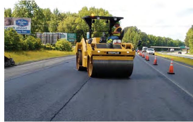
*In der frischen Einbaubahn werden keine Bremsspuren hinterlassen, wenn die Walze zum Anhalten auf eine kalte, bereits verdichtete Einbaubahn fahren kann.*
