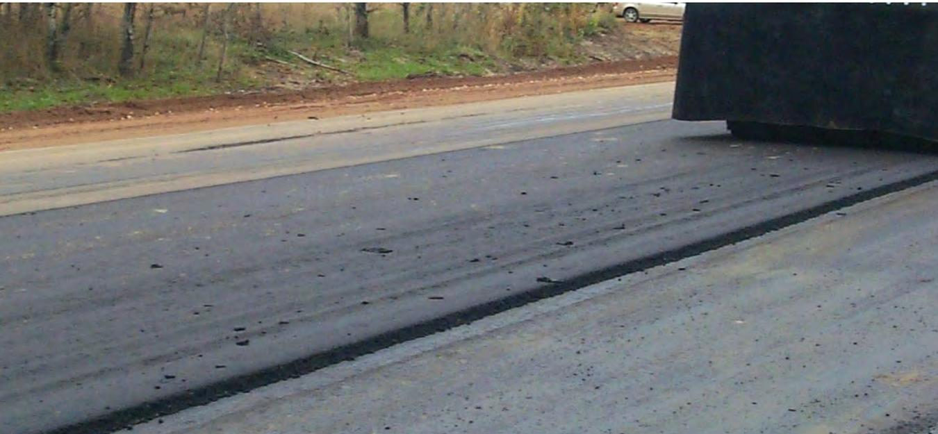
*Heißer Asphalt kann an Gummireifen haften bleiben, und die Klumpen können abfallen und zu einer erheblichen Verschlechterung von Ebenheit und optischer Erscheinung führen.*
