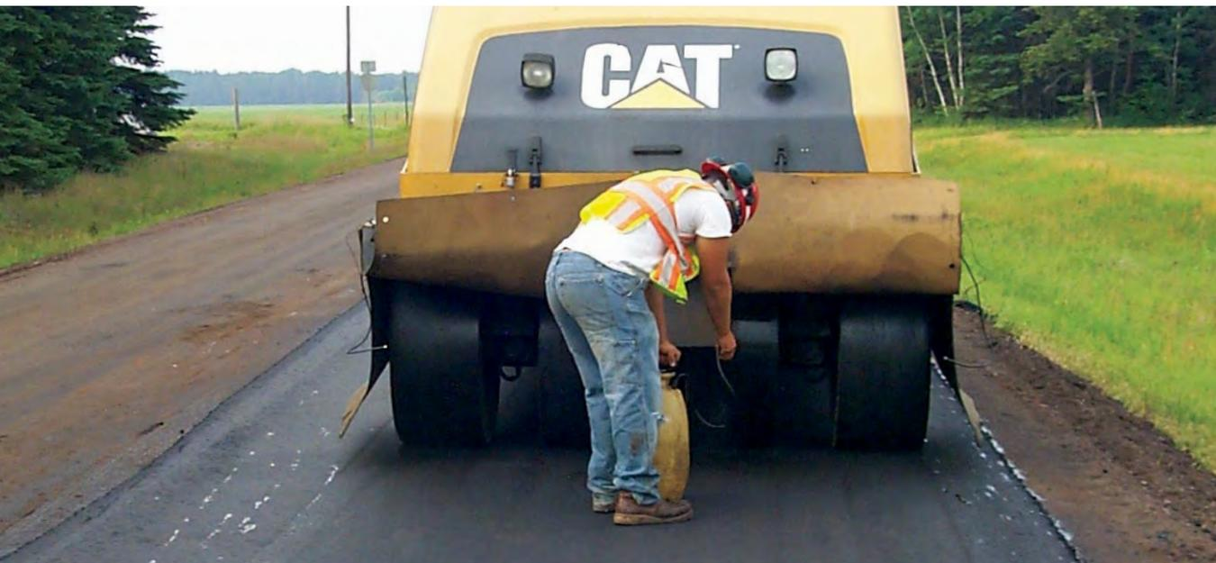
*Trennmittel können mittels eines Sprühkanisters oder der Reifen-Berieselungsanlage der Walze aufgebracht werden.*
