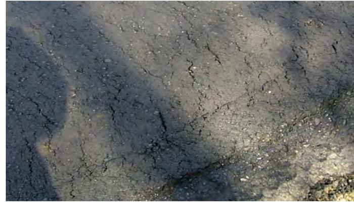
*Durch die Außenkante der Bandage wurde der frische Asphalt gestreckt und deformiert.*
