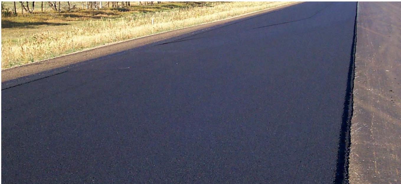
*Eine wichtige Voraussetzung, um eine erstklassige Längsnaht zu erzielen, ist eine gerade Kante für die Nahtverbindung.*
