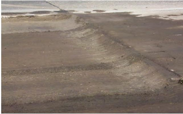
*Beispiel für einen schlechten Start. Eine gewölbte Flanke mit tiefem Einbruch behindert das Verdichten.*
