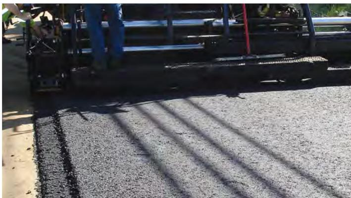
Vom Fertiger wird eine Keilnaht mit Stufe eingebaut.
