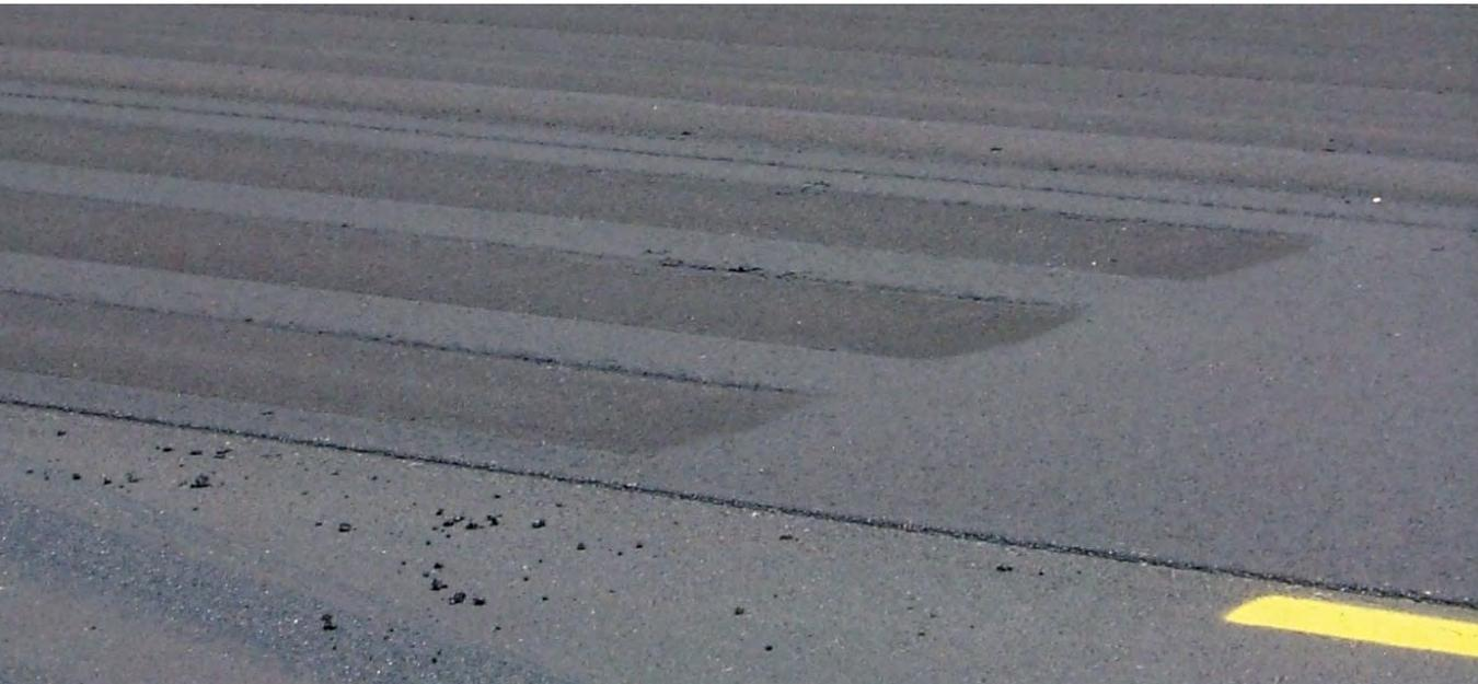
*Gummiradwalzen dürfen aus der Geradeausfahrt heraus auf der Einbaubahn angehalten werden.*
