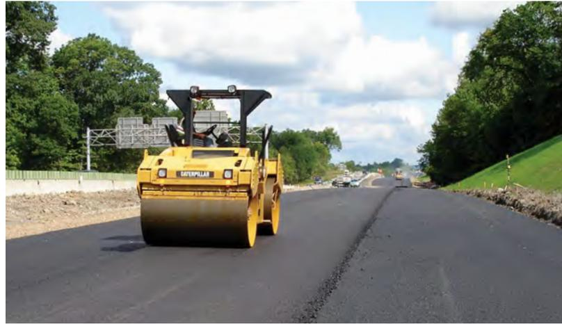
*Während der Endverdichtungsphase üblich sind Tandemwalzen, die im statischen Modus arbeiten.*
