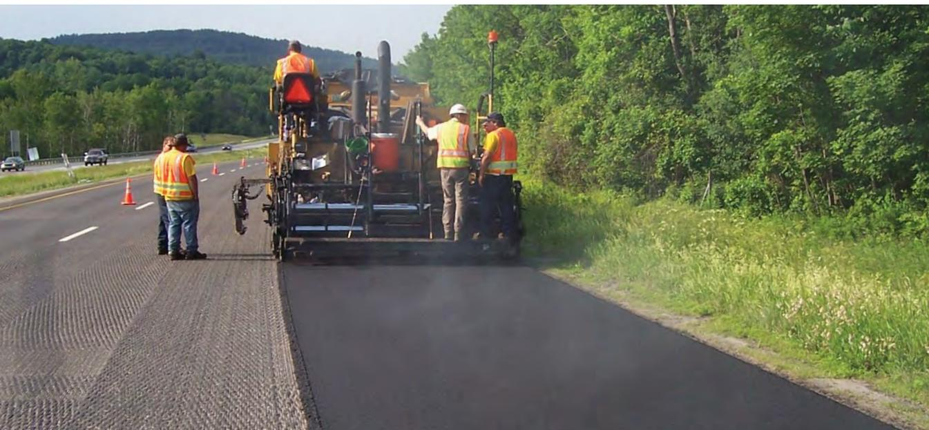
Zum Verdichten dünner Schichten auf gefrästen Oberfläche ist in der Regel weniger Verdichtungskraft erforderlich.
