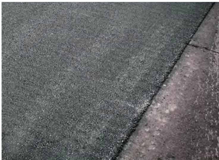
*Oben: Schlagmarken von Vibrationsbandagen. Rechts: Es sollte ein Schema festgelegt werden, durch das der heiße Asphalt beim Reversieren nicht deformiert wird.*
