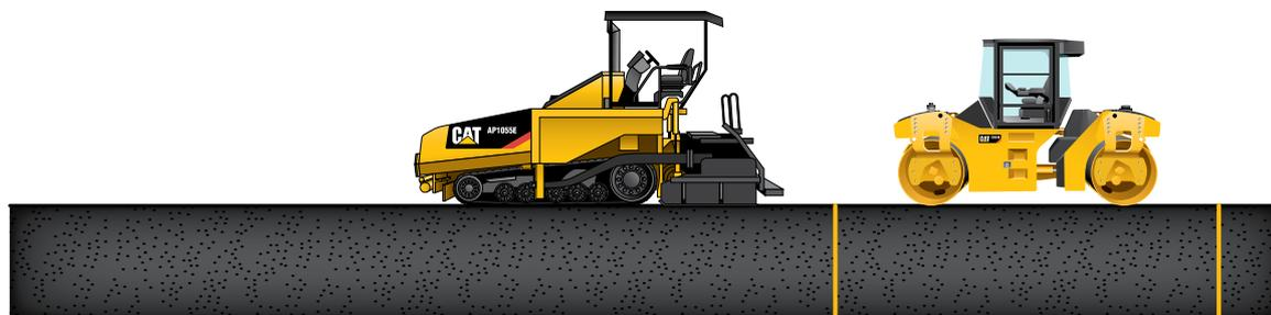
Die Walze, die die Anfangsverdichtung ausführt, arbeitet dicht hinter dem Fertiger.
