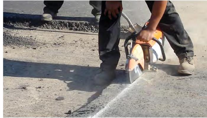
*Das Schneiden oder Fräsen einer geraden vertikalen Nahtflanke ist bei einer Quernaht unabdingbar.*
