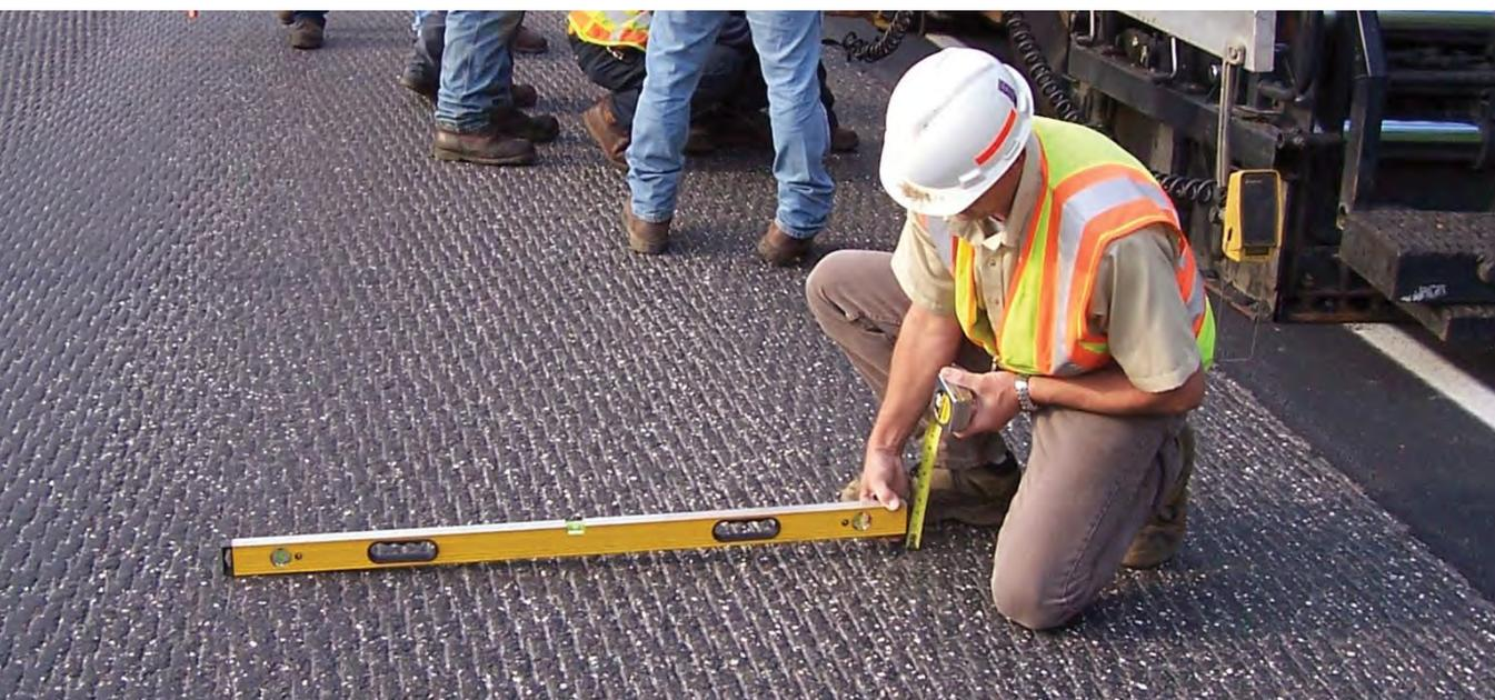
*Wenn vom Einbauteam eine Nivellierautomatik (Slope Control) verwendet wird, kann die Schichtdicke variabel sein.*
