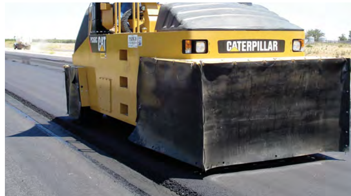
Os compactadores de rodas pneumáticas sempre ficam a uma distância de 15 cm (6") das bordas não confinadas.
