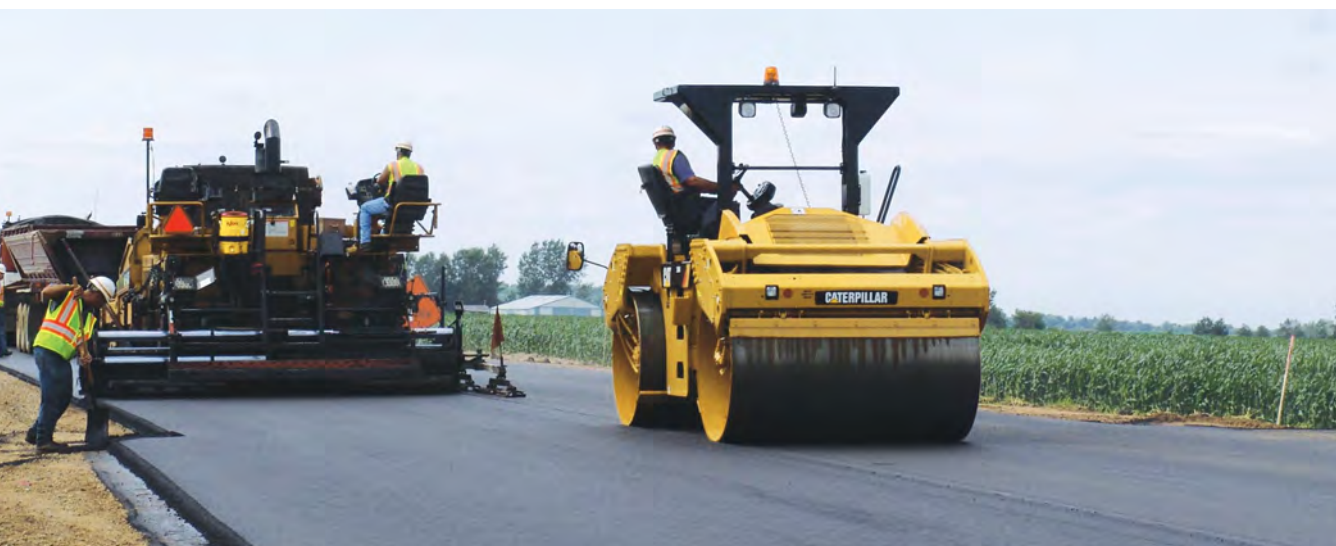
A vedação da junta longitudinal durante a primeira passada melhora sua aparência.
