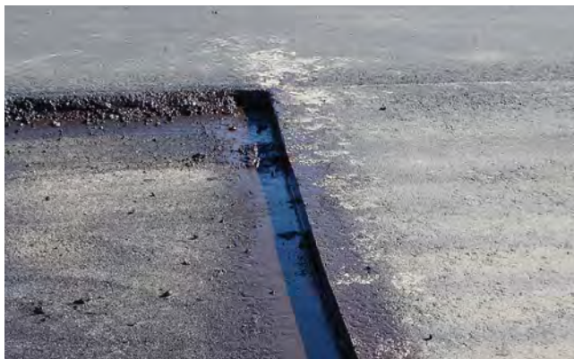
Exemplo de uma junta bem fresada que recebeu pintura de ligação antes do início da pavimentação.
