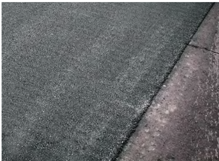
Marcas de impactos do rolo, acima. À direita, estabeleça um padrão que não distorça o asfalto quente quando voltar de ré.
