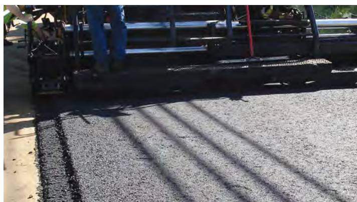
Uma junta chanfrada sendo espalhada pela pavimentadora.
