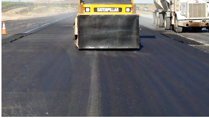
Os compactadores de rodas pneumáticas na fase intermediária são efetivos na vedação de juntas longitudinais quentes / frias.
