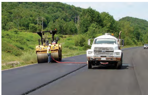
Compactador estacionado no acostamento durante o reabastecimento de água (esquerda) para evitar fazer marcas na camada de pavimentação na pista de deslocamento. Providencie uma maneira para que o compactador possa sair da camada de pavimentação com bordas não confinadas, se necessário.
