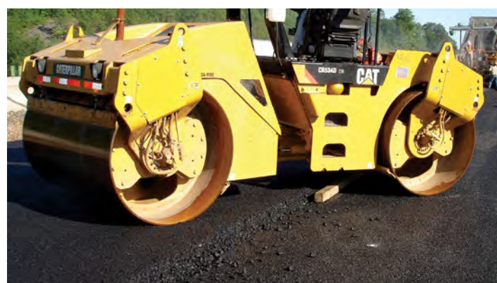
Compactador estacionado no acostamento durante o reabastecimento de água (esquerda) para evitar fazer marcas na camada de pavimentação na pista de deslocamento. Providencie uma maneira para que o compactador possa sair da camada de pavimentação com bordas não confinadas, se necessário.
