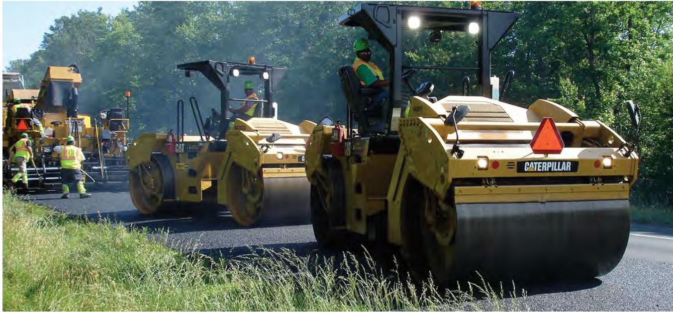
Dois compactadores da fase inicial invertendo a direção atrás da pavimentadora. Note o ângulo da parada.
