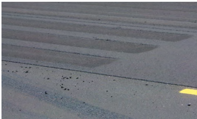
As marcas de pneus deixados pelo compactador de rodas pneumáticas normalmente podem ser eliminadas pelo compactador da fase de acabamento.
