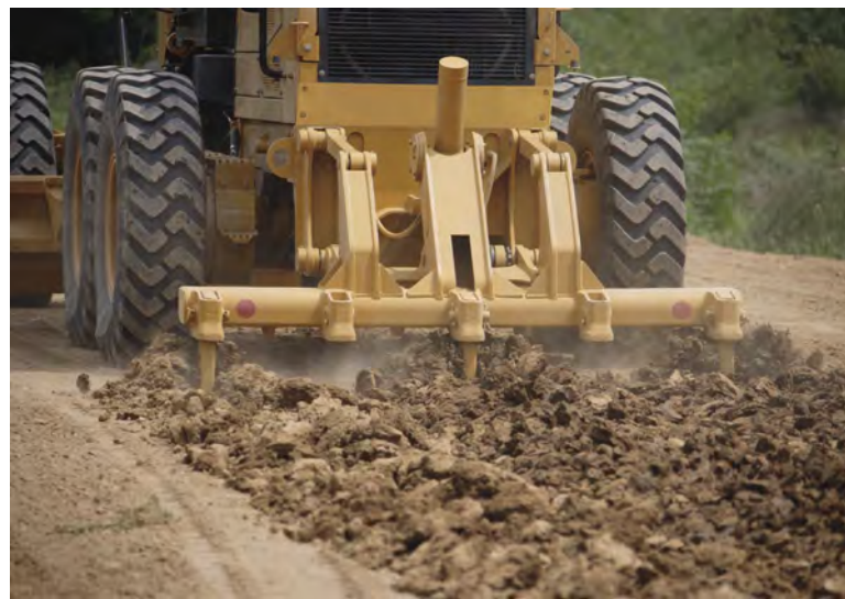
Quand la teneur en eau est trop élevée, l'ouverture du sol accélère le temps de séchage.
