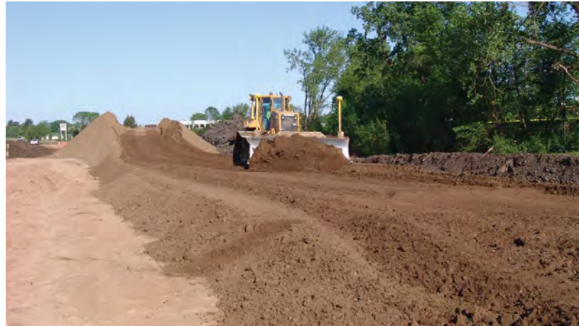
Préparation d'un site d'essai
