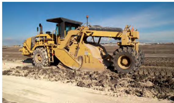
La stabilisation du sol améliore les qualités techniques d'un sol.
