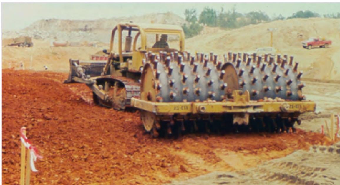
Кулачки «шипфут» проникают в грунт сверху и действительно уплотняют слой грунта внизу. При выходе кулачка из грунта он отбрасывает вверх или разрыхляет материал. В результате на поверхности образуется рыхлый слой материала. При отсыпке еще одного слоя верхний слой будет разрыхлен, а предшествующий слой уплотнен. Катки «шипфут» действительно осуществляют уплотнение снизу вверх.
