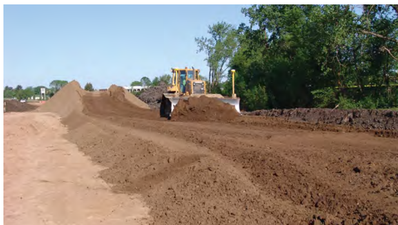
Preparazione di un sito di prova
