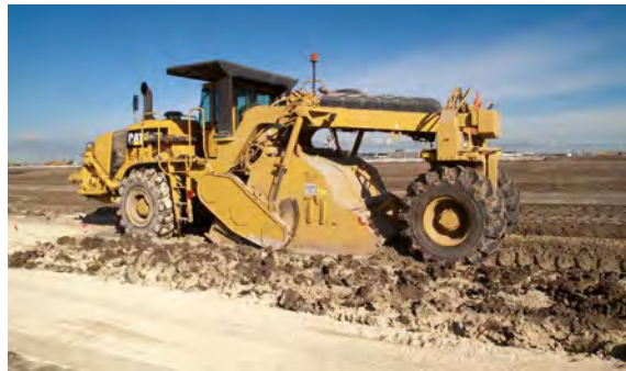
La estabilización del suelo mejora la calidad del mismo.
