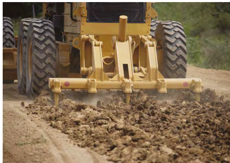
Cuando el contenido de humedad es muy alto, se abre el suelo para acelerar el tiempo de secado.
