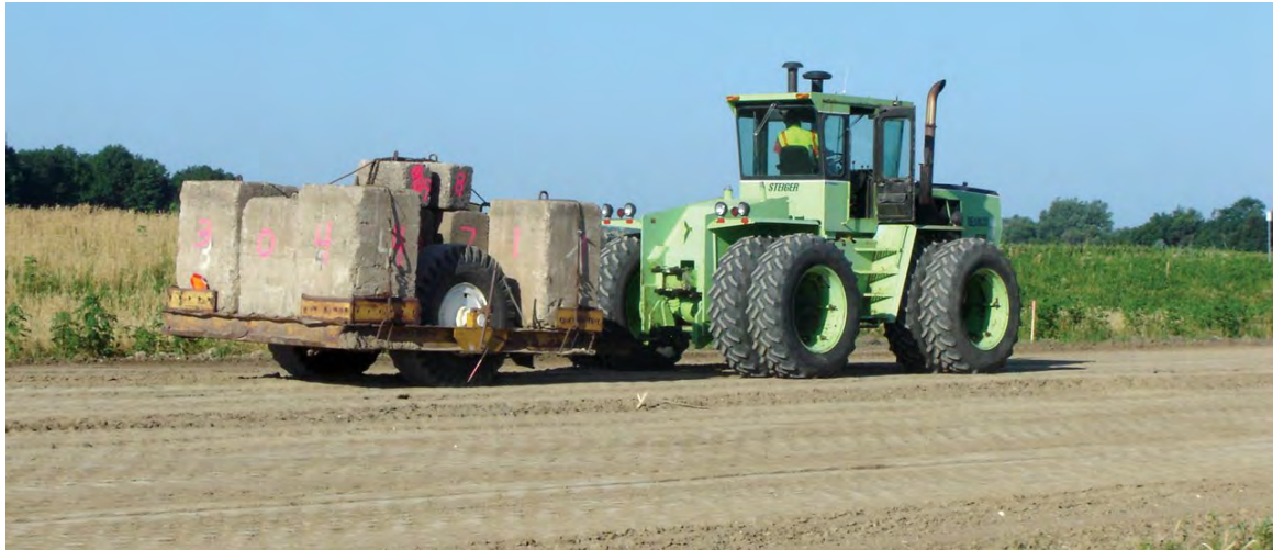
Einsatz des Proof-Rolling-Verfahrens zur Überprüfung der Stabilität und Gleichmäßigkeit der verdichteten Schicht
