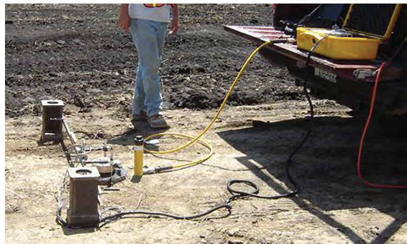
Vorbereitung eines Lastplattendruckversuches
