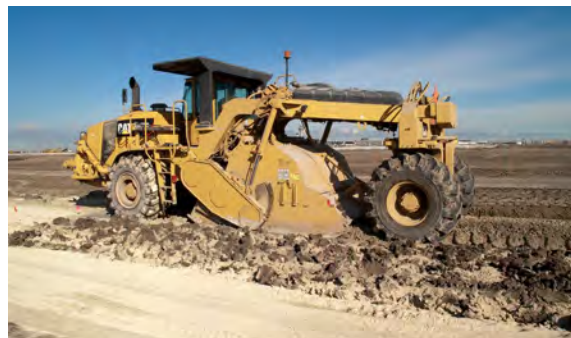
Durch die Bodenstabilisierung werden die bautechnischen Eigenschaften eines Bodens verbessert.
