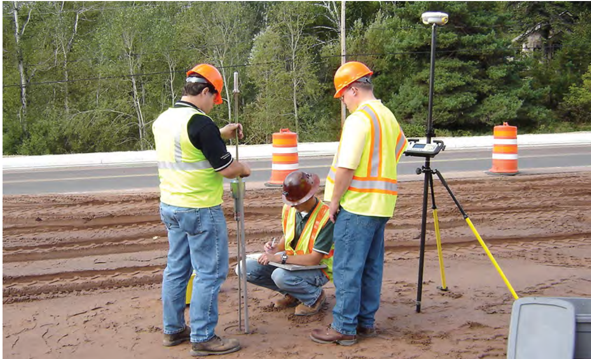
Eine Rammsonde im Einsatz
