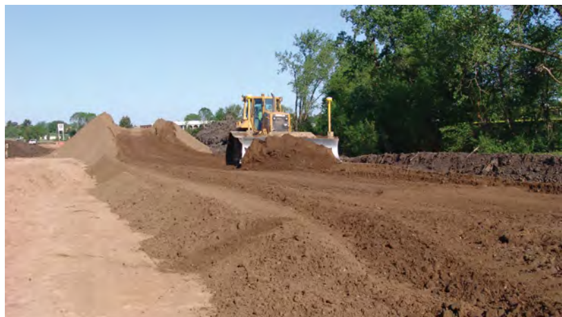
Vorbereitung eines Prüfbereichs
