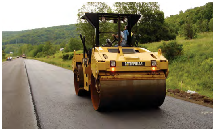
Вибрационные катки, используемые на промежуточном этапе, работают в режиме низкой амплитуды.
