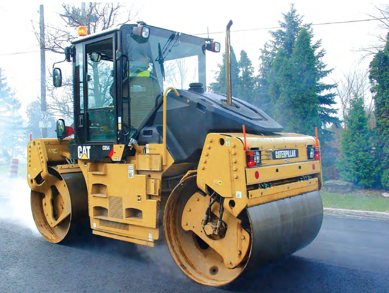
Каток Cat CD54, выполняющий начальный этап уплотнения
