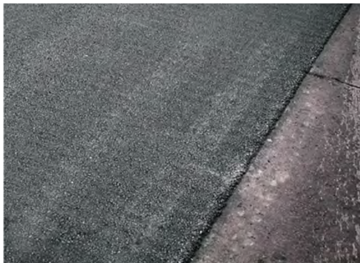
Следы от ударов вальцов на фотографии выше. Справа - применение схемы укатки, не деформирующей горячий асфальт при реверсировании направления движения.
