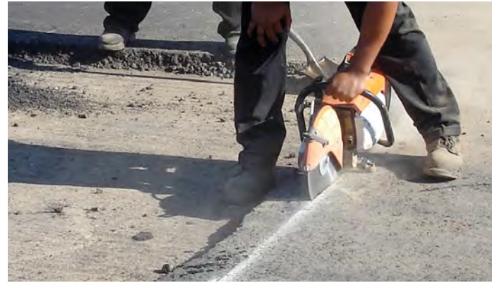
Для поперечного шва необходимо формирование прямой вертикальной грани путем резки или фрезерования.
