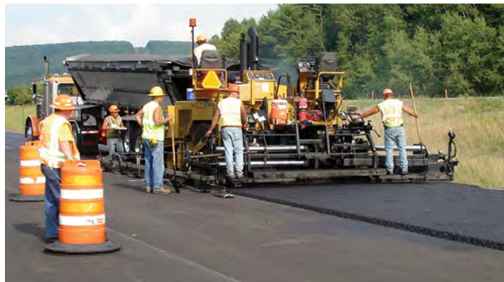
Создание вертикального края полосы без бокового упора путем перемещения торцевого щита выглаживающей плиты в плавающем положении по поверхности асфальтируемой дороги
