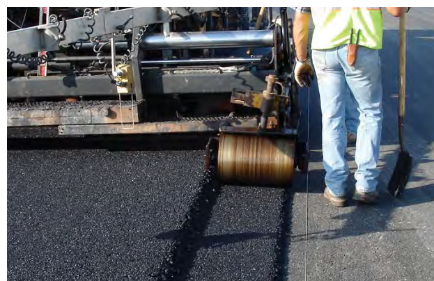
При устройстве клиновых швов с уступом могут использоваться прицепные катки
