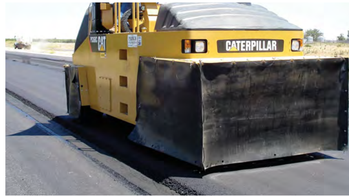
Пневмоколесные катки всегда следуют с отступом по крайней мере 15 см (6 дюймов) от краев без боковых упоров.
