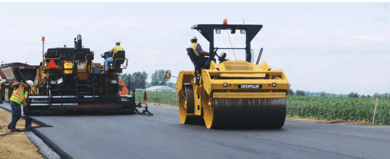
Уплотнение продольного шва во время первого прохода улучшает внешний вид шва.
