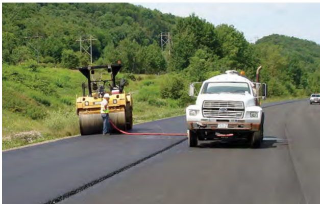
Слева каток, остановленный во время заправки водой на обочине, для того чтобы исключить образование вмятин на полосе движения. Справа применение при необходимости средств для съезда катка с полосы, край которой не имеет бокового упора.
