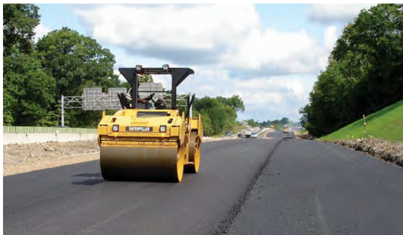
Для заключительного уплотнения обычно применяют двухвальцовые катки, работающие в статическом режиме.
