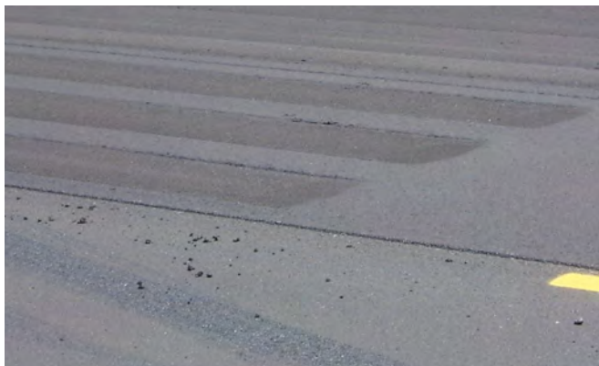
Следы от шин пневмокотка обычно можно устранить катком на заключительном этапе уплотнения.
