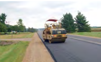
Каток остановленный под углом с частичным заездом на обочину.
