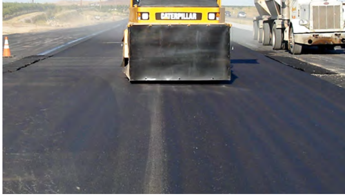
Les compacteurs pneumatiques de phase intermédiaire sont efficaces pour le scellement des joints longitudinaux chauds/froids.
