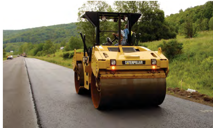
Les compacteurs vibrants utilisés dans la phase intermédiaire sont réglés sur une faible amplitude.
