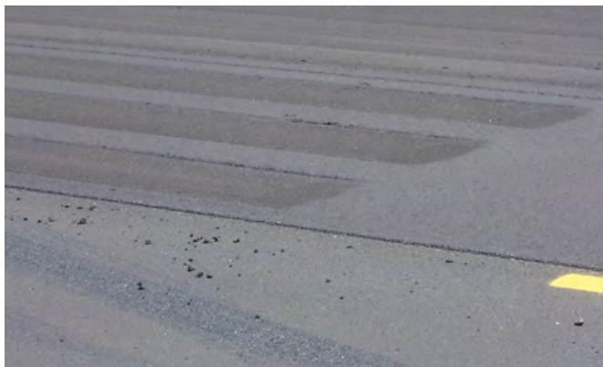
Il est normalement possible d'éliminer les marques de pneus, laissées par un compacteur pneumatiques, avec un compacteur de phase finale.
