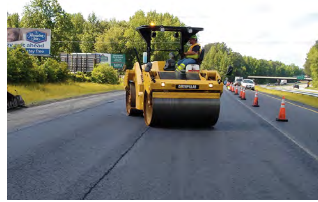
Il n'existe aucune marque d'arrêt de cylindre sur le revêtement frais lorsque le compacteur a la possibilité de s'arrêter sur un revêtement compacté et froid.
