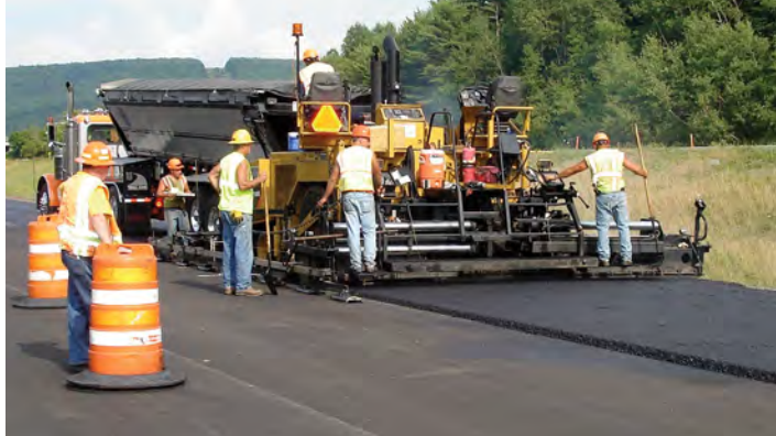
Création d'un bord vertical libre en laissant la porte latérale de la table de pose en position flottante, sur le revêtement en cours de pose.
