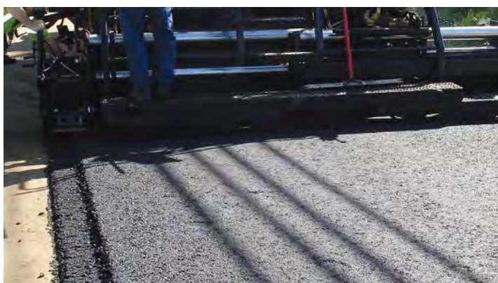
Un joint en biseau avec entaille posé par le finisseur.
