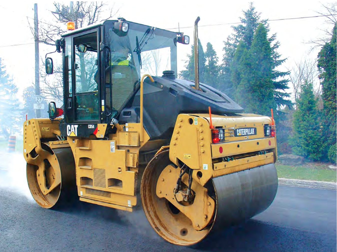
Un Cat CD54 au travail pendant la phase initiale du compactage.
