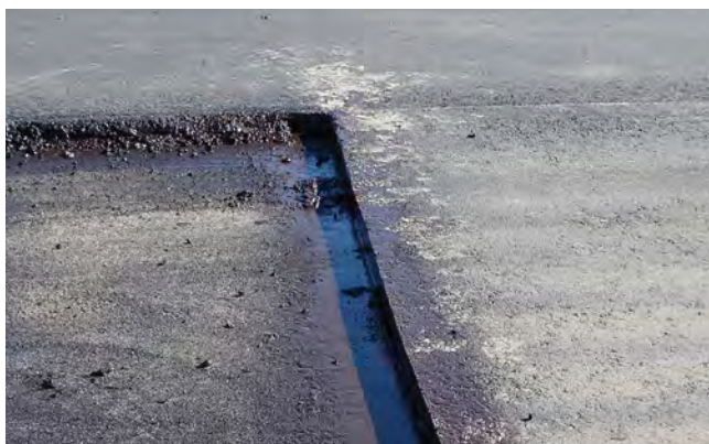
Exemple d'un joint bien découpé à la scie, puis ayant été enduit de primaire avant le début de la pose.
