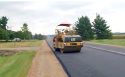
Compacteur arrêté et partiellement stationné sur un épaulement.
