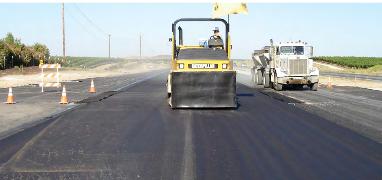
Compacteur pneumatiques scellant un joint longitudinal chaud/froid.
