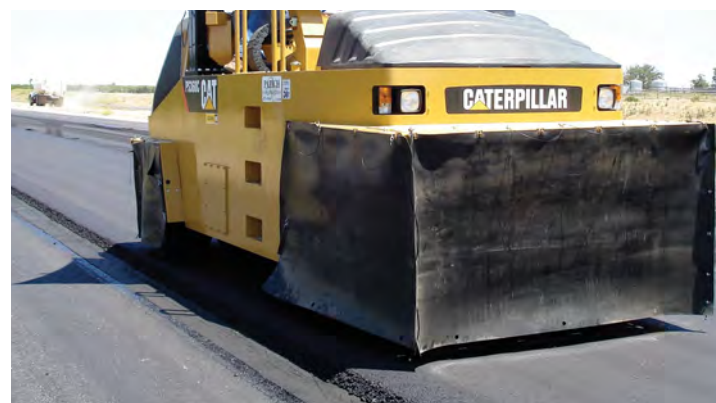
Les compacteurs pneumatiques restent toujours à au moins 15 cm (6") des bords libres.
