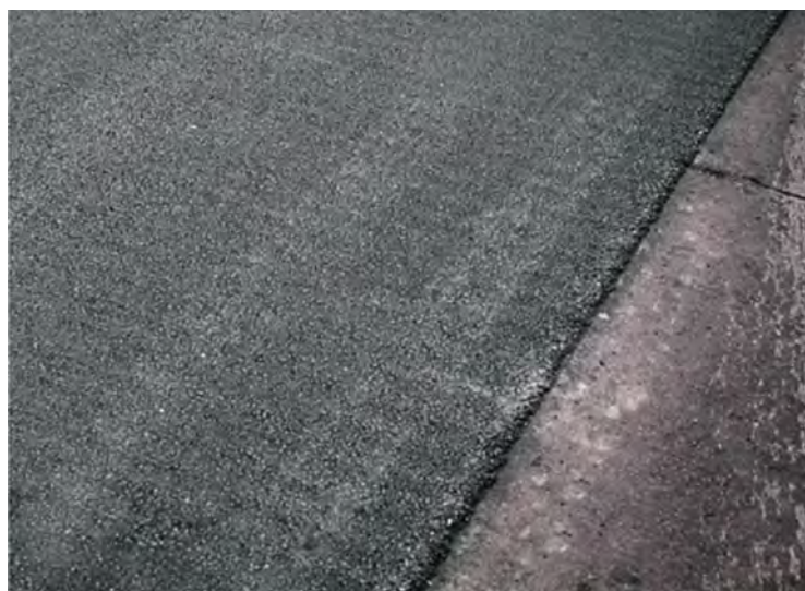
Marques de choc du cylindre, ci-dessus. À droite, élaboration d'un modèle qui ne déforme pas l'enrobé chaud lors du changement de direction.
