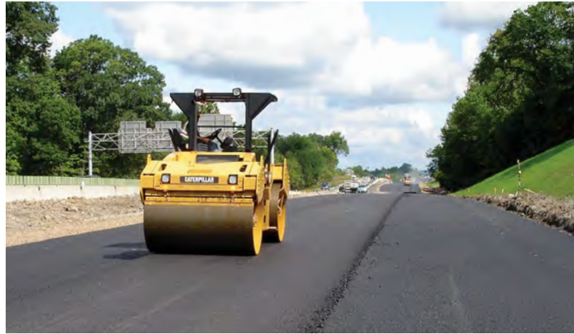
Les compacteurs tandem en mode statique sont communs pendant la phase de finition.
