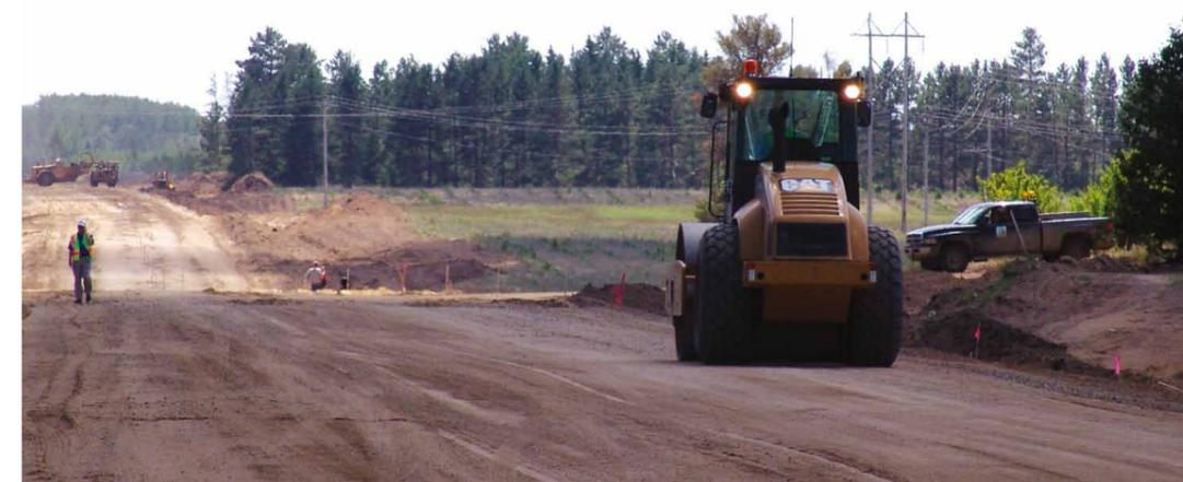
9. Continue repetindo o passo 8 até o nível de compactação entre as passadas não mude substancialmente, ou até que o compactadores comece a descompactar.
