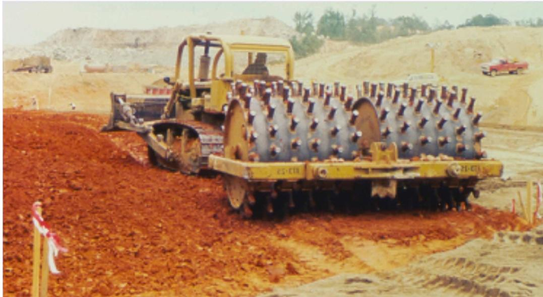
As patas nos rolos pé de carneiro penetram através do topo da camada a ser compactada e, na verdade, compactam a camada inferior. Quando um ressalto sai do solo, ele afoga o material. O resultado é uma camada solta de material na parte de cima. Quando mais camada é espalhada, a camada superior fica ainda mais fofa e a camada anterior é compactada. Um compactador equipado com rolo pé de carneiro compacta realmente de baixo para cima.
