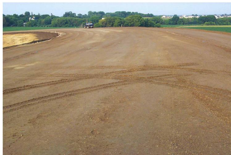
constantes, a espessura uniforme da camada gerará uma densidade uniforme em todo o canteiro de obras. Negligenciar a espessura da camada pode resultar em não ser possível atender às especificações da obra.
