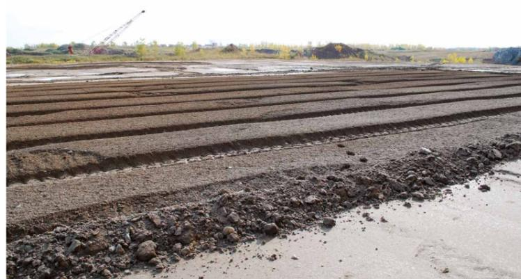
a compactação na próxima camada terá resultados variados e indesejáveis. Cada camada deverá ser uniforme e totalmente compactada para assegurar que as próximas camadas também sejam compactadas com sucesso.
