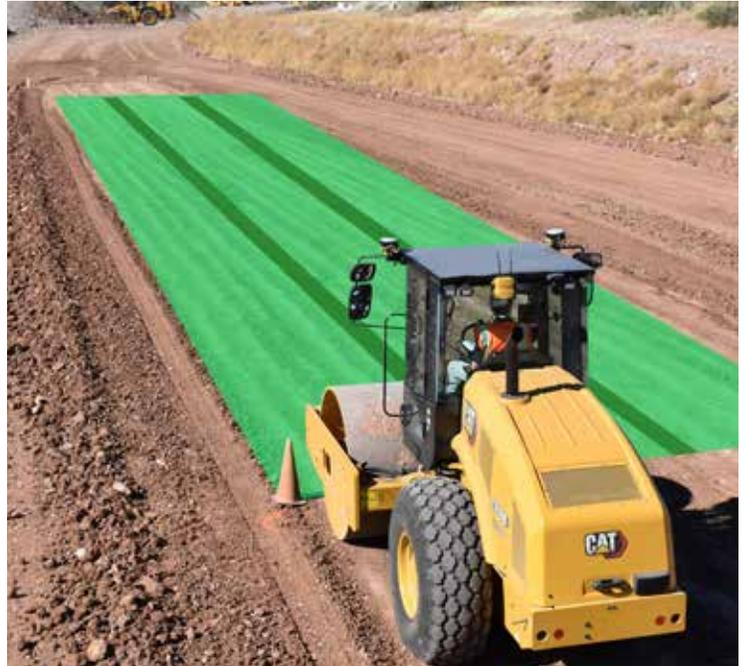
COMMAND PROPORCIONA UNA SUPERPOSICIÓN Y UN CONTEO DE PASADAS CONSISTENTES PARA LOGRAR UNA COMPACTACIÓN MÁS UNIFORME.
