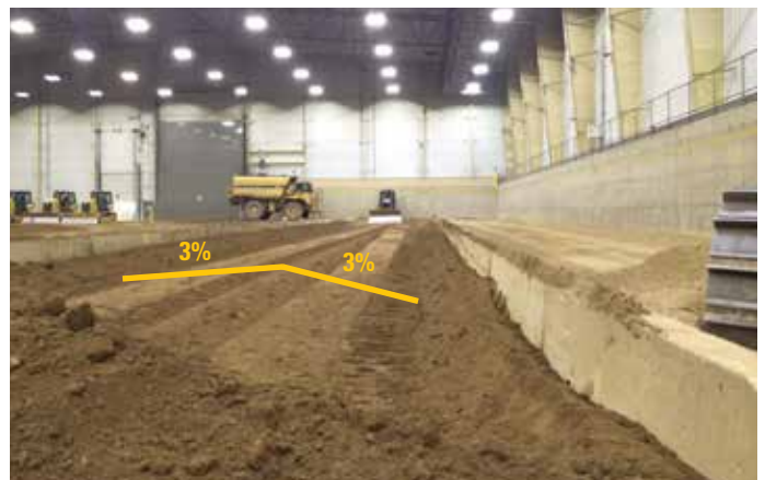
Mit Slope Assist ging es leicht und schnell von der Hand, eine Straße mit einer 3-prozentigen Querneigung anzulegen.
