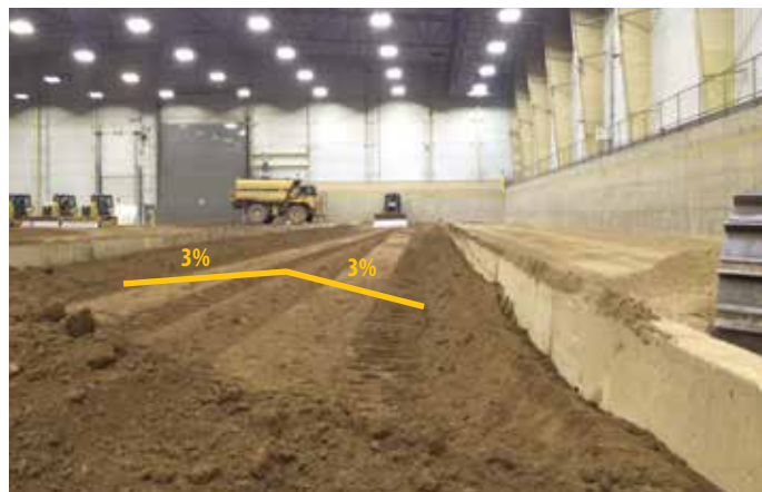
Układ Slope Assist ułatwił szybką pracę przy budowie drogi z obustronnym 3-procentowym spadkiem.
