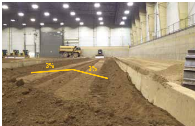
Grazie a Slope Assist è stato possibile costruire rapidamente una strada con un colmo del 3%.
