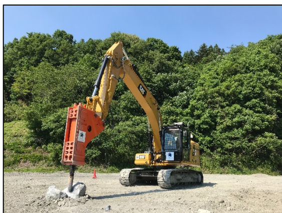
第一段階：自律制御による割岩作業
