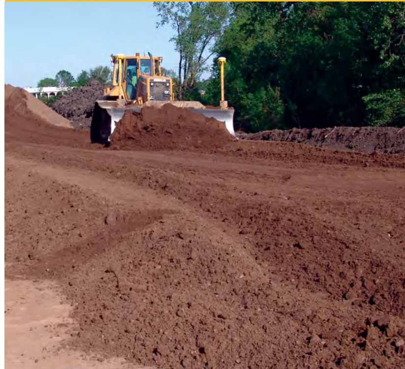
Construir una sección de prueba.
