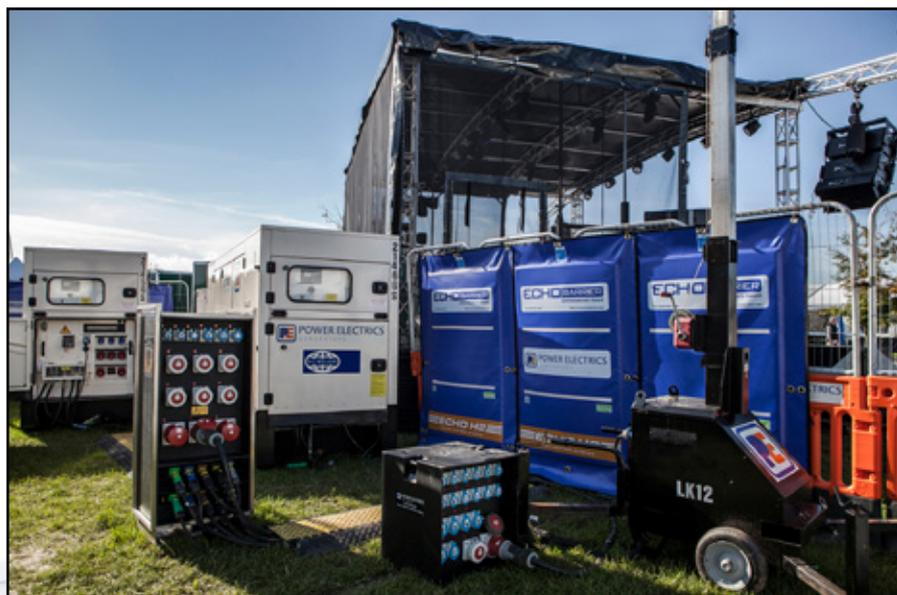
Две генераторные установки мощностью 200 кВА обеспечивают основное и резервное питание для праздничной сцены в Сомерсете (Великобритания).
