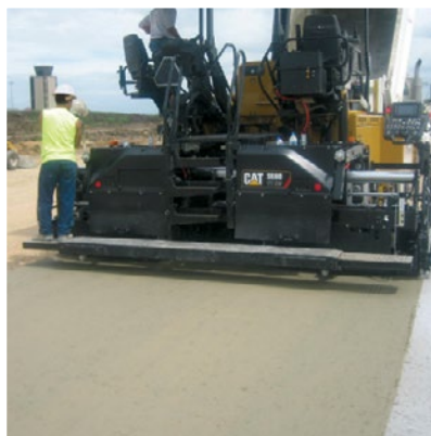
^ AP655F/SE60 VT XW Mistura de RCC (Roller Compacted Concrete, Concreto Compactado a Rolo)
