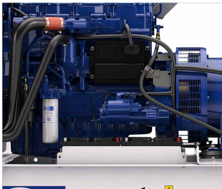
La revisión y el mantenimiento son rápidos y sencillos gracias a un acceso fácil a los componentes. Los drenajes de aceite lubricante y de líquido refrigerante proporcionan la accesibilidad necesaria para el mantenimiento, mientras que el depósito de combustible y el reloj están situados juntos para que el rellenado y la supervisión resulten sencillos.
