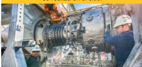
El intercambio de la turbina se realiza en el sitio.
