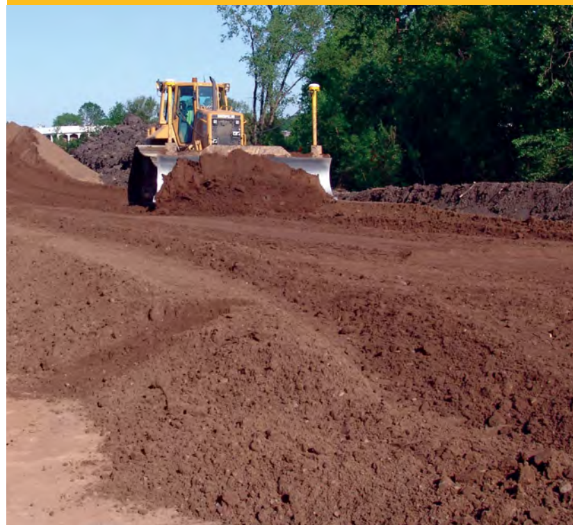
Construindo uma área de teste.
