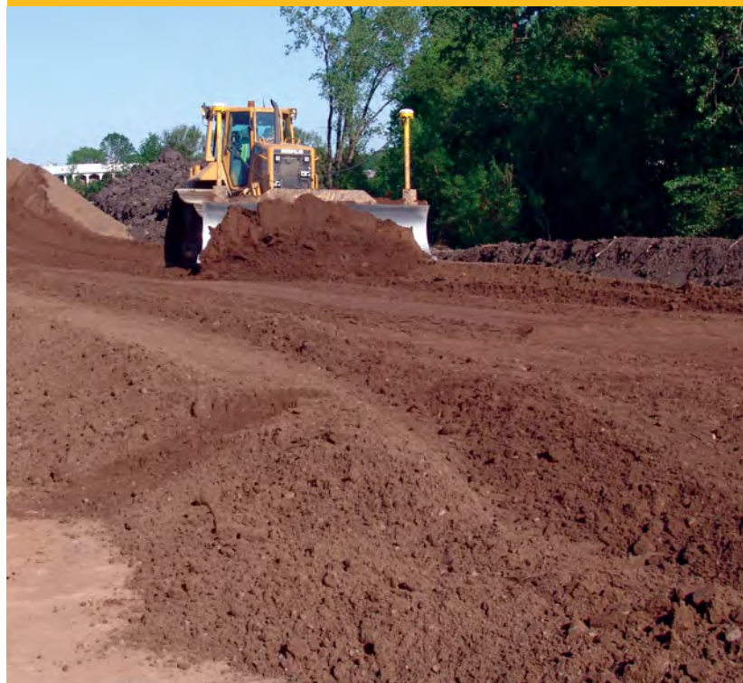
Устройство участка пробной укатки.
