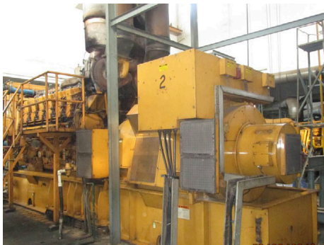
Dos Grupos Electrógenos de Aceite para Hornos 3612 Cat® han proporcionado energía a Din Textile Mills, Ltd. desde 1997.
