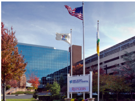
En 2011, Saint Peter's se embarcó en una iniciativa de ahorro de energía que incluyó una mejora integral de los sistemas eléctricos del hospital.
