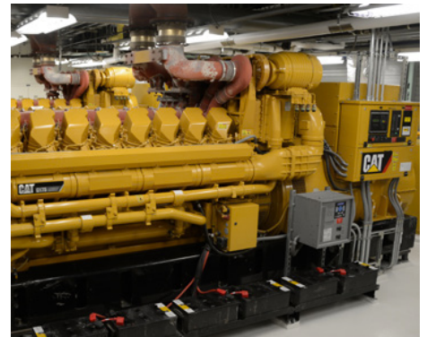
El C175-16 de Caterpillar, que se presentó en 2008, se utiliza en todo el mundo en una variedad de aplicaciones, y probó su alta fiabilidad y durabilidad.
