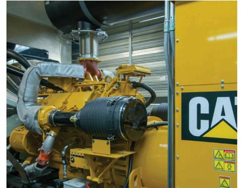
*El grupo electrógeno diésel Cat® C32 suministra potencia de respaldo de emergencia para los sistemas de seguridad vital y otras operaciones en las instalaciones de TRMC, que cuentan con 191 camas.*
