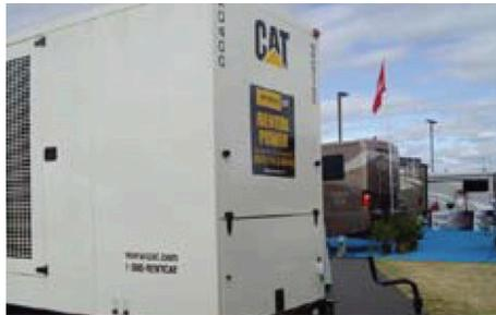
Wayne Power Systems instaló tres Cat® Grupos electrógenos diésel 3516B para 6,75 MW de poder para proporcionar hasta dos semanas de emergencia energía de respaldo en caso de un corte de energía.
