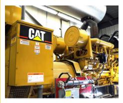
La actualización en KCI incluyó los paneles de control de los grupos electrógenos, así como los PLC, relés y software HMI del tablero de distribución.
