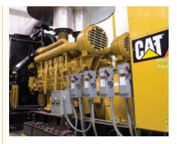
Cuatro grupos electrógenos diésel Cat® 3516C producir 10 MW de energía para proporcionar servicios esenciales Necesidades de energía de emergencia para Cape Fear Pabellón Valley del Valley Medical Center, Paciente Torre de Servicios y Planta Central de Energía.
